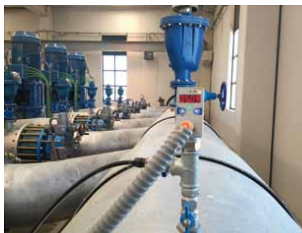
Medición de la presión en el colector de impulsión.
